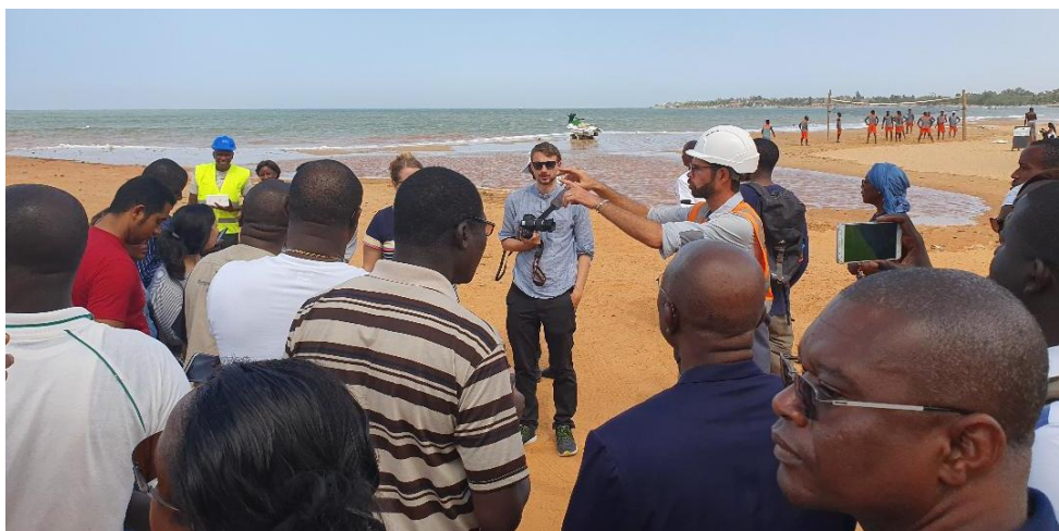
Les participants visitent le site de Saly (plage récupérée par la mise en place d'ouvrages de protection du littoral)
